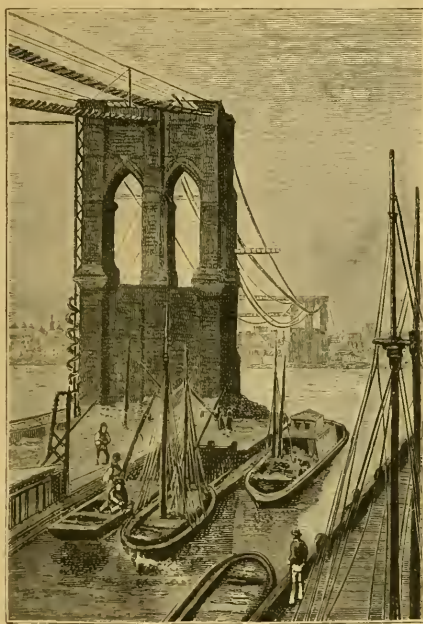
FIG. 200. — PILE DU PONT, DU CÔTÉ DE NEW YORK
